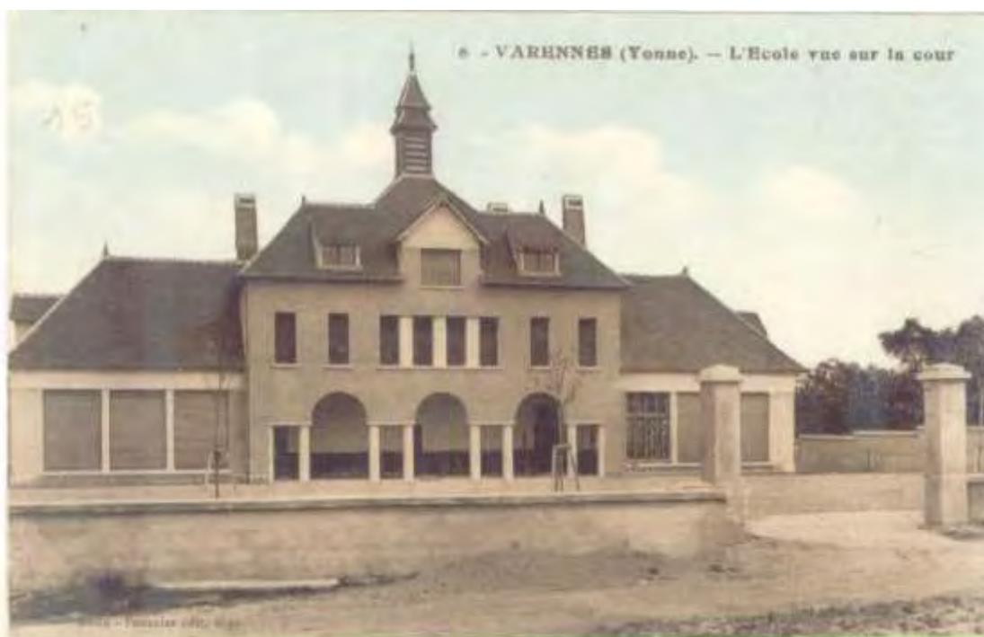
La nouvelle école côté cour
