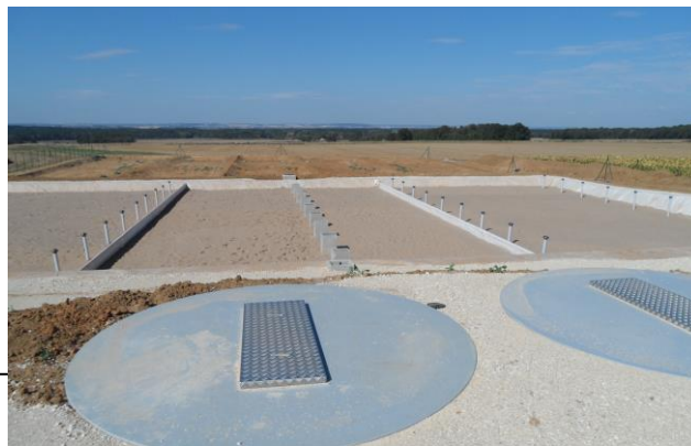
Le bassin de filtres à sable plantés de roseaux (sans les roseaux...) au premier plan : les chasses d'eau.
