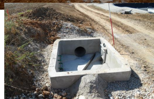
Le déversoir d'orage
