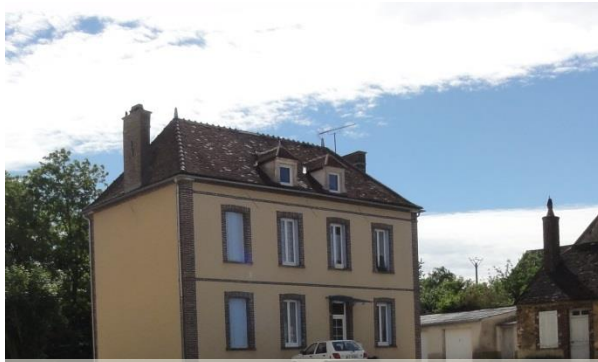
Bâti R + 1 + combles
